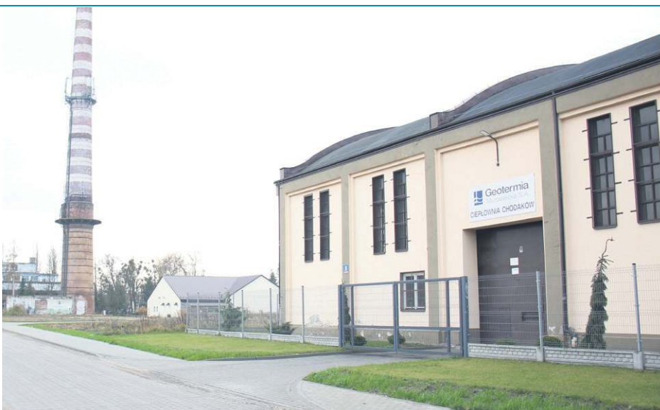
Miejski punkt sprzedaży węgla uruchomiony zostanie na tyłach kotłowni Geotermii Mazowieckiej w Chodakowie
