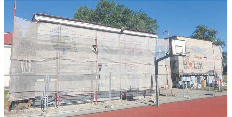
Trwa ocieplanie ścian hali, łącznika i budynku administracyjnego SP nr 7
