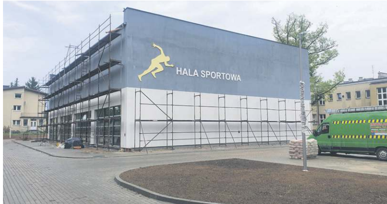
Elewacja hali sportowej SP 2 jest już prawie gotowa
