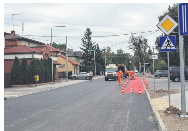
Od jesieni jeździmy przebudowaną na całej długości ul. 15 Sierpnia
