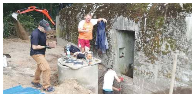
Renowacja bunkra przy ul. Lubiejewskiej
