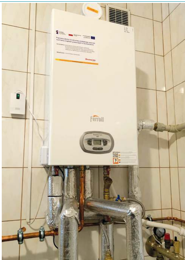
W grudniu ratusz zakończył realizację projektu „Poprawa jakości środowiska miejskiego poprzez wymianę urządzeń grzewczych w Sochaczewie”. W jego ramach, z pomocą UE, w niemal czterdziestu domach wymieniono nieefektywne piece na ekologiczne źródła ciepła
