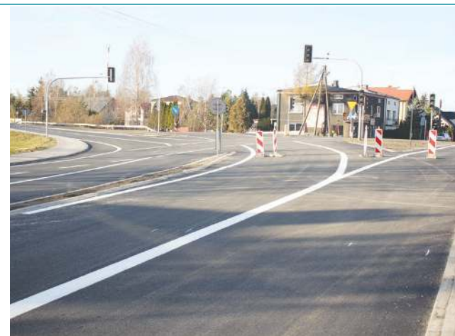
W ul. Płockiej deszczówkę poprowadzono pod skrzyżowaniem
