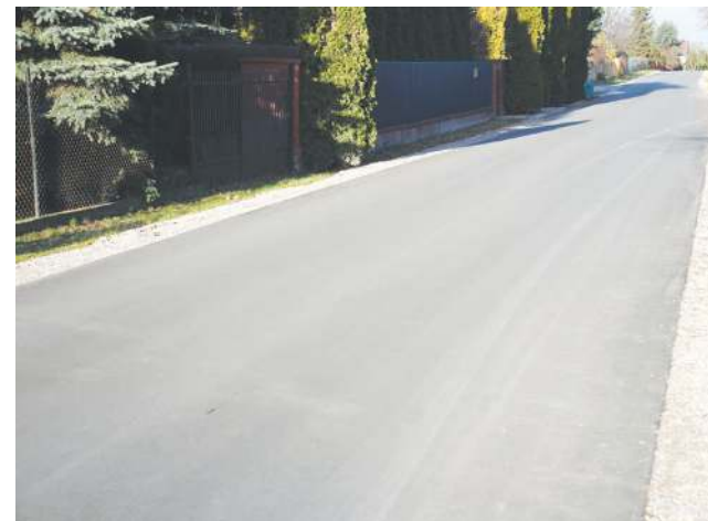
Nowy asfalt na ul. Królewskiej
