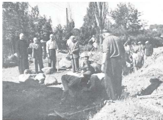
Wrzesień 1959 r. - Pierwsze wykopy pod fundamenty nowego kościoła. W tle ówczesny proboszcz Zygmunt Dejciński
