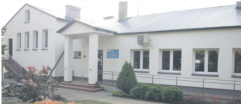
W 72 proc. za termomodernizację budynku Środowiskowego Domu Samopomocy zapłaciły władze samorządowe Mazowsza.
