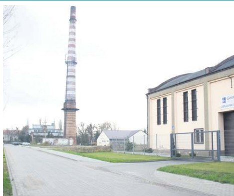
W 100 proc. za odwodnienie dróg na terenie Chemitexu oraz budowę deszczówki w ul. Płockiej zapłaciły NFOŚiGW i Fundusz Inwestycji Lokalnych
