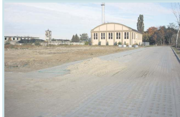
Drogi położone w centralnej części dawnych zakładów chemicznych zyskały także chodniki
