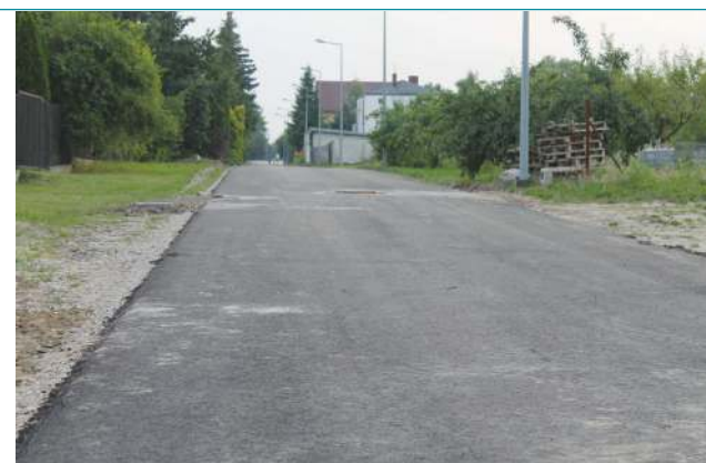
Ulica Rolnicza już z pierwszą warstwą asfaltu
