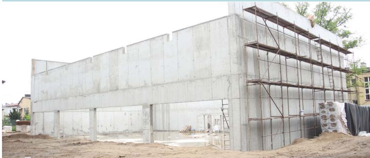
Szkielet nowej sali gimnastycznej przy boryszewskiej „dwójce” jest już gotowy
