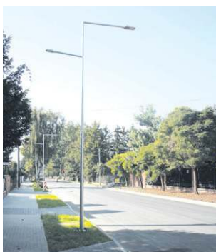
Na drugim odcinku ul. 15 Sierpnia stanie ponad 30 lamp
