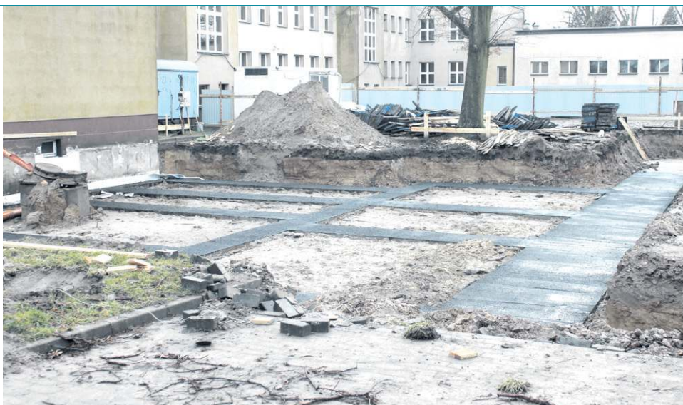
Budowa sali gimnastycznej przy SP nr 2 ruszyła pod koniec ubiegłego roku
