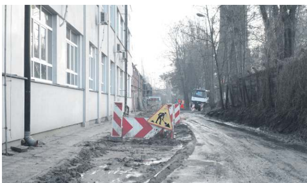
Ulica Włókiennicza na terenie Chemitexu w trakcie przebudowy. Jesienią będzie tu deszczówka i utwardzenie
