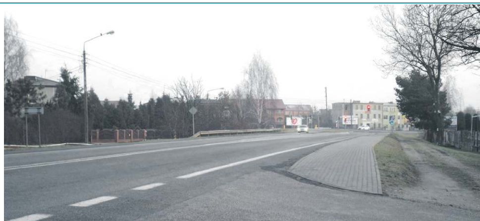
Od strony Kuznocina kanalizacja deszczowa sięgnie do ulicy Rolniczej
