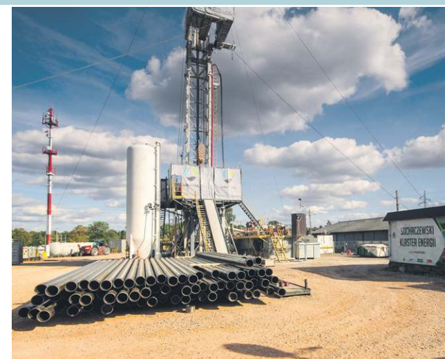
Odwiert geotermalny wykazał, że pod Sochaczewem płynie słodka i ciepła woda
