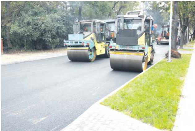
Pierwszy odcinek ul. 15 Sierpnia już niemal gotowy. Drugi fragment tej drogi będzie przebudowany w 2021 roku
