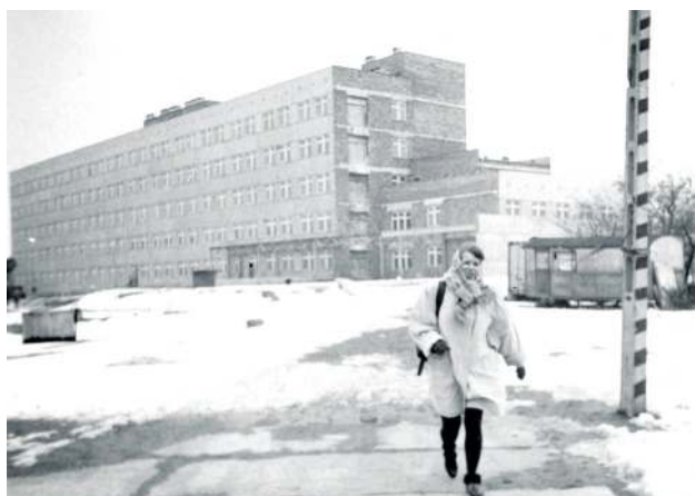
Budowa szpitala trwała 20 lat, zakończyła się w 1995 roku
