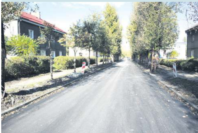
Pod Topolową naprawiono i wymieniono odcinki kanalizacji deszczowej. Od kilku dni droga jest utwardzona asfaltem
