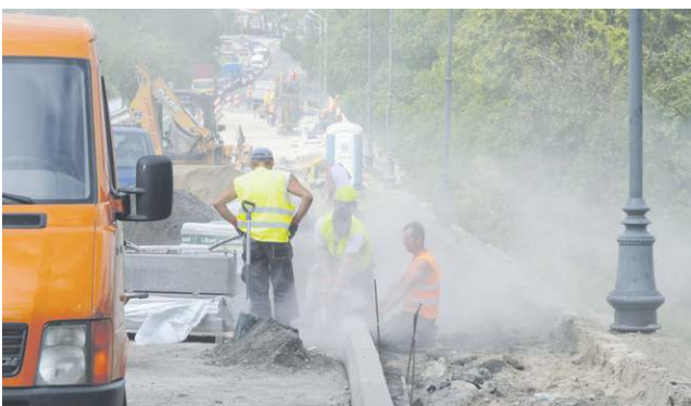
Rok 2016 - trwają prace na najważniejszym moście w Sochaczewie
