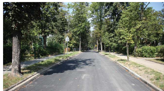
Parkowa z nową nawierzchnią i pełnym odwodnieniem
