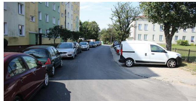
Ul. Grunwaldzka - na dużym odcinku odtworzono nawierzchnię asfaltową
