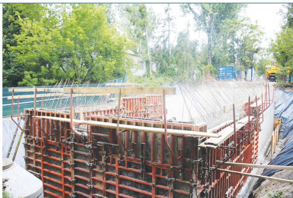
Postęp prac przy budowie zbiornika w Chodakowie jest imponujący
