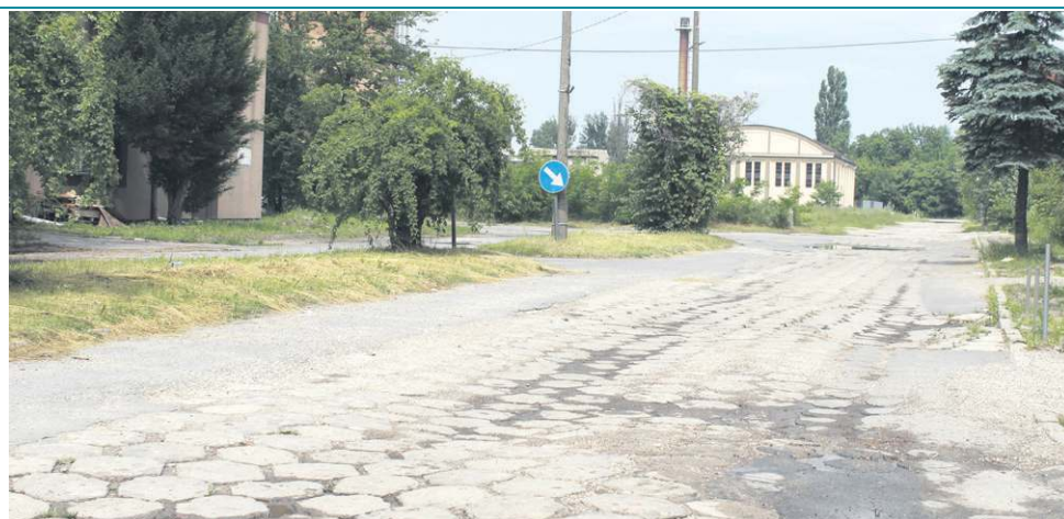
Ulica Wiskozowa już wkrótce zyska nową nawierzchnię
