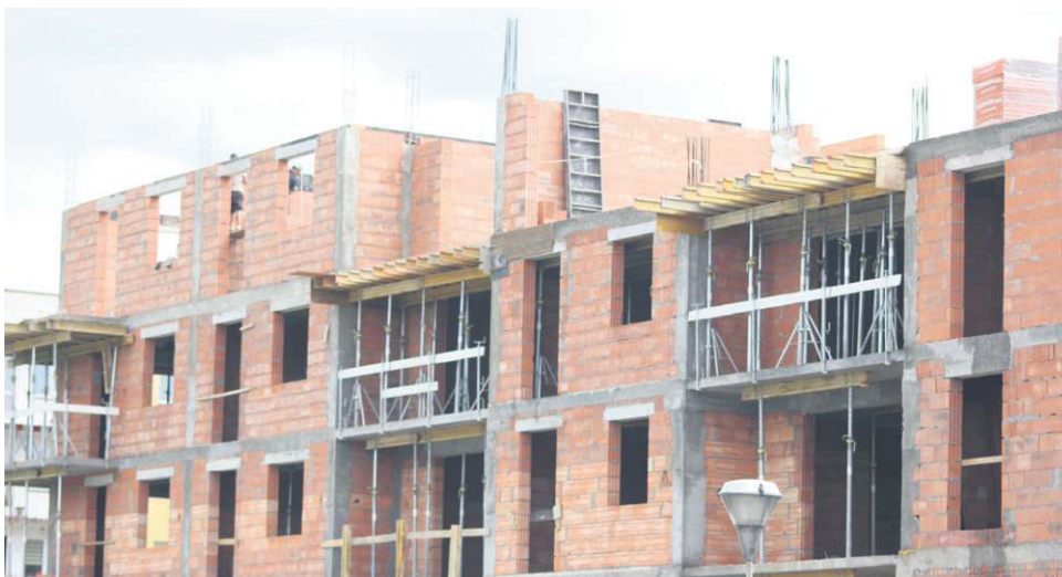
Trwa budowa bloku na działce po dawnej siedzibie telekomunikacji
