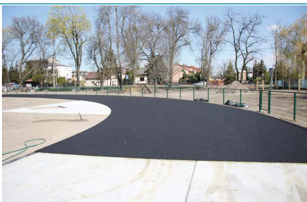
Trwają prace związane z układaniem nowej, syntetycznej bieżni
