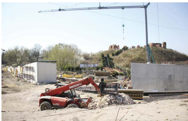
Pomiędzy tymi budynkami powstanie scena amfiteatru
