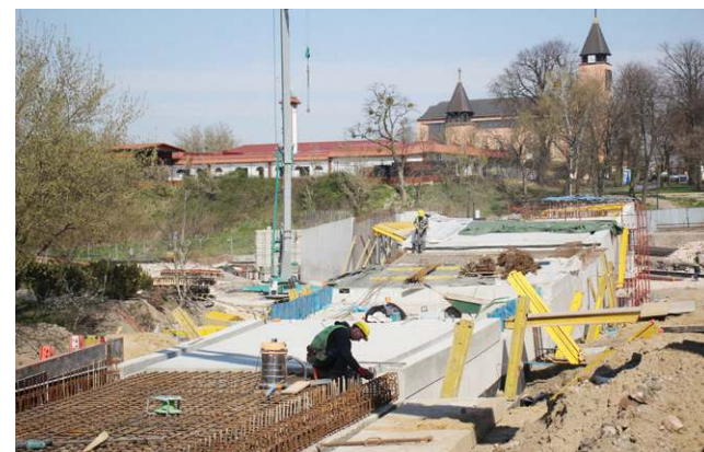
Prace trwają nieprzerwanie. Nawet zima nie spowolniła budowlanców
