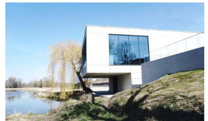
Dzięki specjalnej konstrukcji tarasu udało się nie naruszyć brzegu Bzury dodatkowymi podporami
