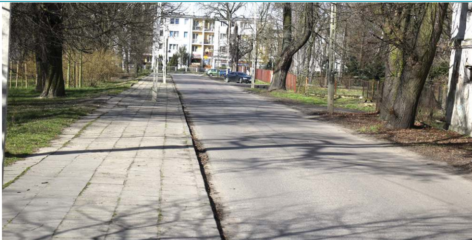
Remont ulicy Głowackiego; wartość zadania: 2.619.916 zł, wkład starostwa i Funduszu Dróg Samorządowych: 2.354.324 zł; wkład miasta: 265.592 zł
