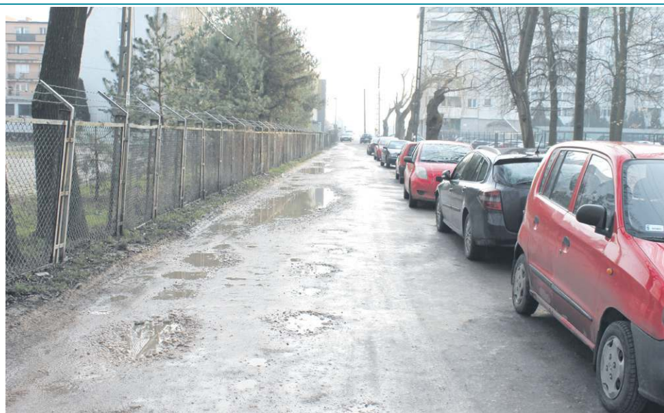
Przebudowa ulicy Ułanów Jazłowieckich pochłonie prawie 800 tys. zł
