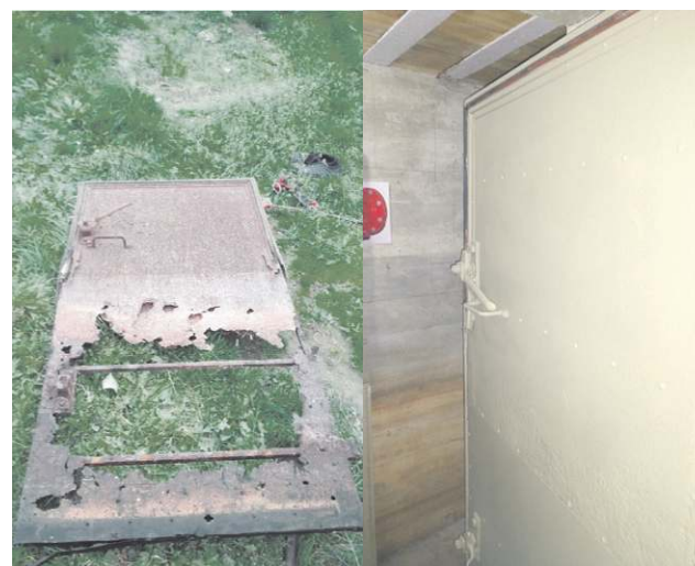
Drzwi zabezpieczające wejście do schronu przed i po renowacji
