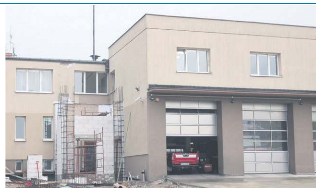
Od zachodniej strony budynku powstaje wieża do suszenia węży
