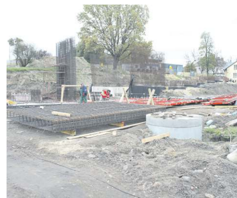
Badania archeologiczne nie przerwały budowy amfiteatru
