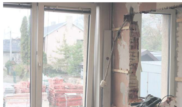
W środku komendy trwa już przebudowa pomieszczeń
