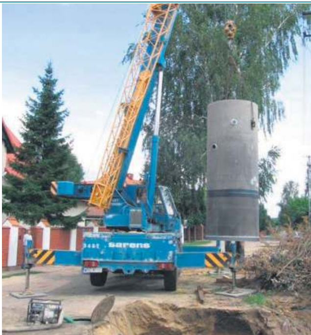
Na skanalizowanie Chodakowa i wypaleniska miasto wydało 30 mln zł
