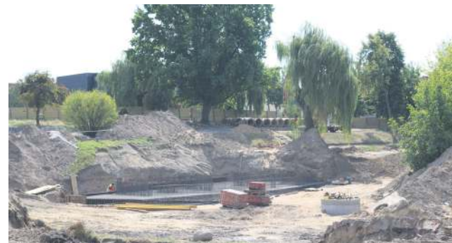
Zbrojenie fundamentów jest już gotowe i czeka tylko na wylanie cementu
