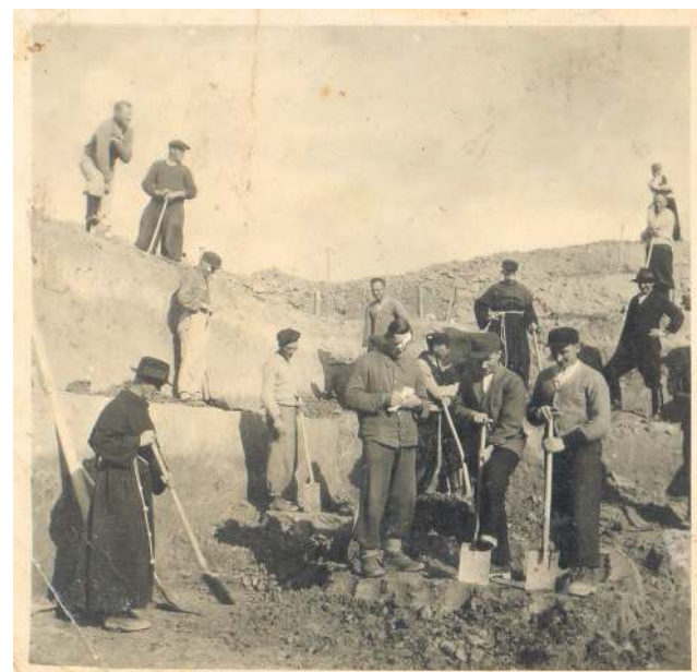
Rok 1944 - Franciszkanie na przymusowych robotach przy budowie schronu
