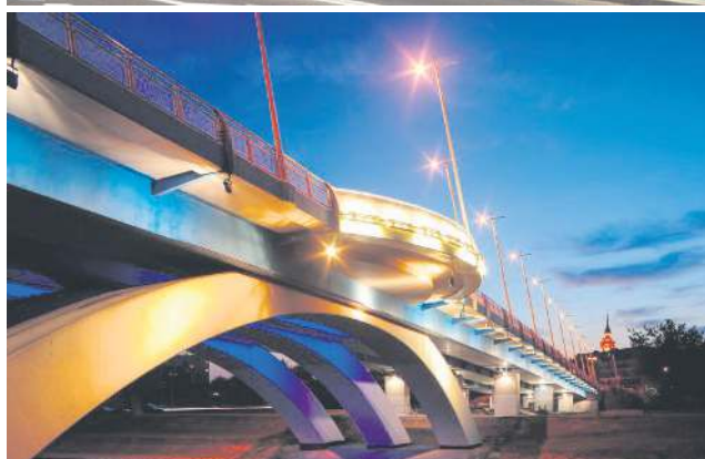
Projekty firmy Promost Consulting zrealizowane w Dobczycach i Rzeszowie
