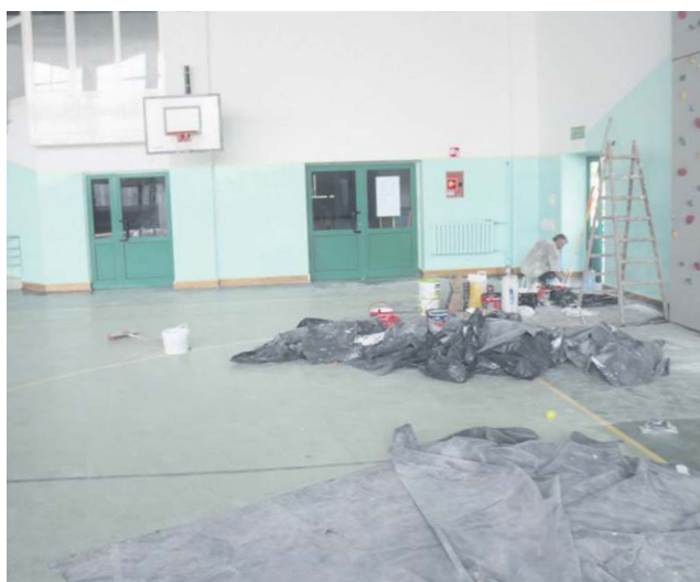
W SP6 rozpoczął się już remont sali gimnastycznej
