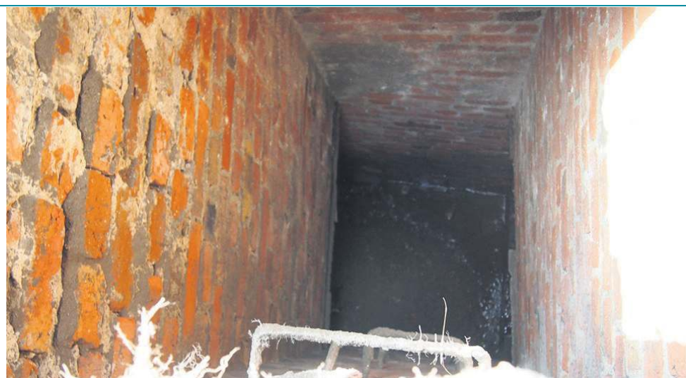
Podczas prac na podzamczu odsłonięto kolejne wejście do Kanału Królewskiego
