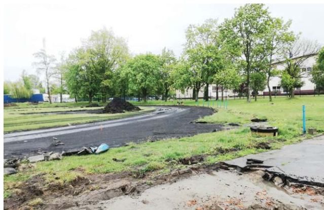
Stadion przy ulicy Warszawskiej w trakcie remontu. Jego przebudowa pochłonie w tym roku prawie 6 mln zł
