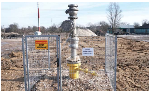
Wieża została rozebrana a odwiert zabezpieczony
