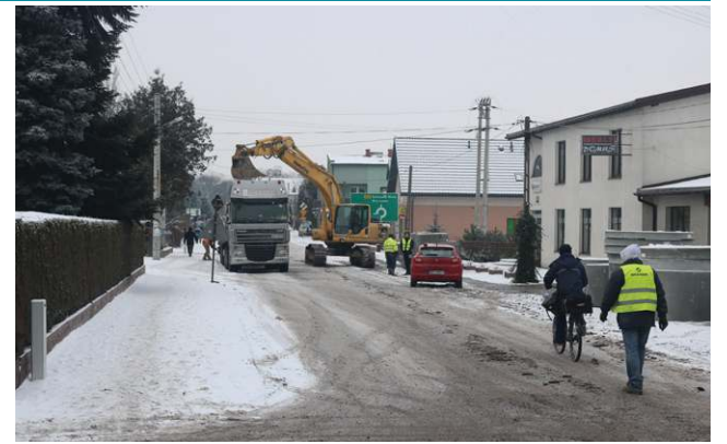
7 stycznia ruszył remont wojewódzkiej ulicy Chopina. Miasto dokłada się do projektu, na własny koszt zbuduje tam oświetlenie uliczne
