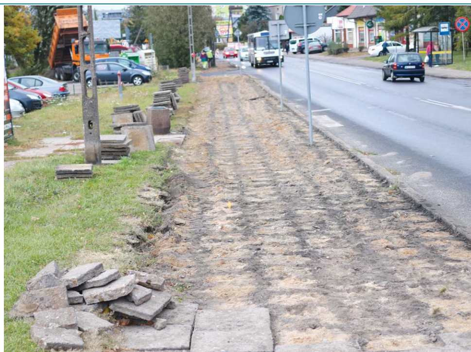
Remont al. 600-lecia rozpoczął się od wymiany chodników
