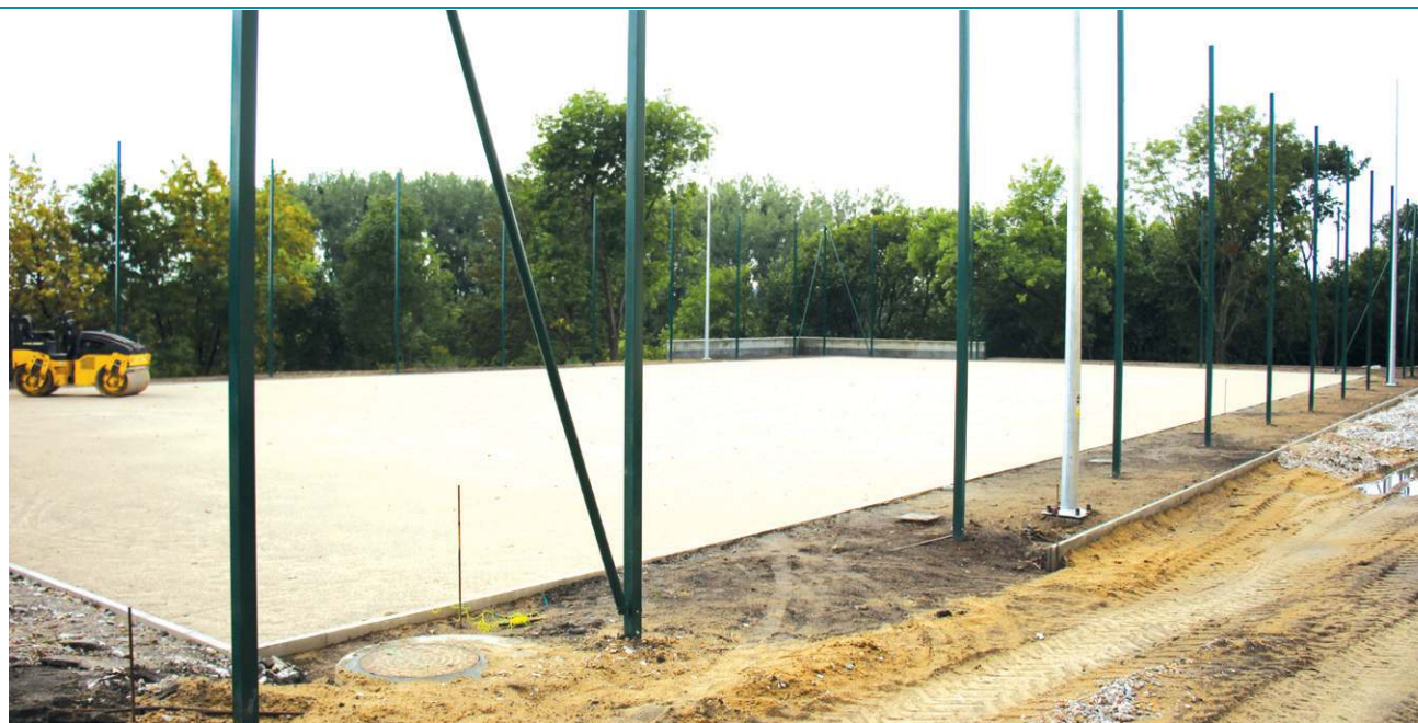
Boisko wielofunkcyjne na tyłach czwórki jest już prawie gotowe. Koszt jego budowy to prawie milion złotych
