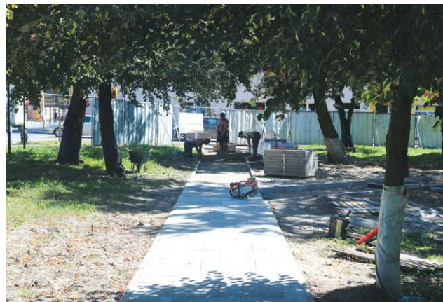
Nowa nawierzchnia ścieżek w parku przy Traugutta
