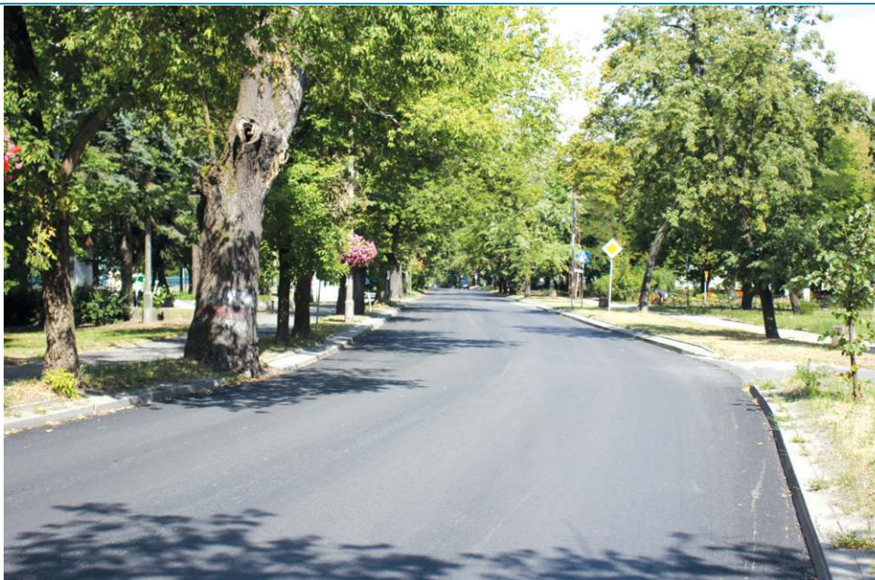
Zanim rozpocznie się remont omawianego fragmentu ul. Chopina, MZDW modernizuje jezdnię od ronda Jana Pawła II do granic miasta
