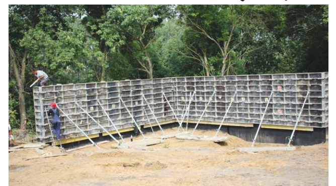
Mur oporowy na skarpi przy SP4
