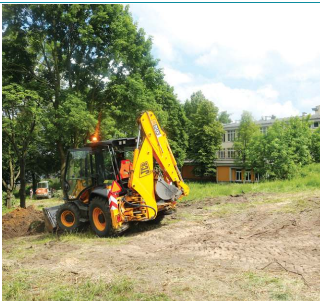
Budowę boiska przy „czwórce” rozpoczęto od równania terenu
