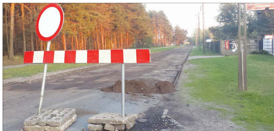
W czasie remontu drogi właściciele domów i firm tam zlokalizowanych mają mieć zapewniony dojazd do swoich posesji
