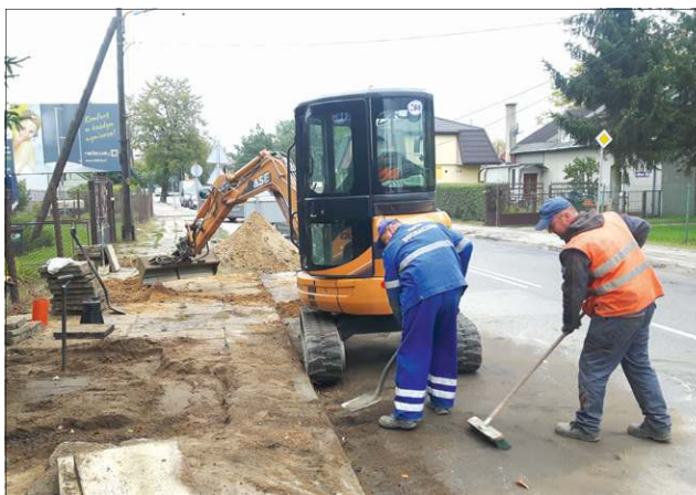
Ul. Chopina. W ubiegłym roku, przygotowując się do remontu drogi, ZWiK wymienił w niej cały wodociąg
