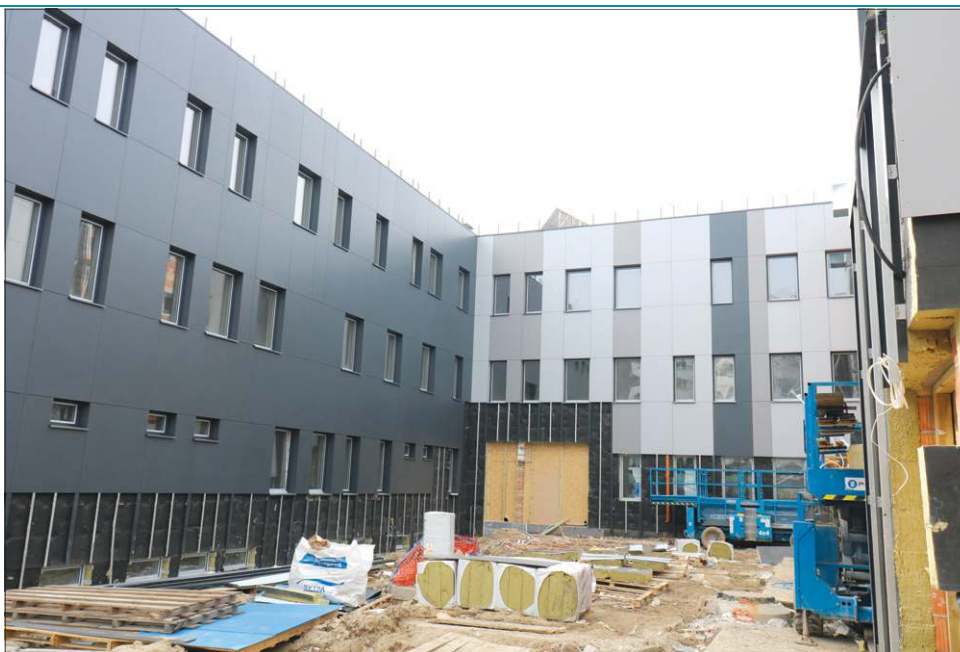
Od strony parkingu budynek jest już prawie w całości pokryty płytami elewacyjnymi
