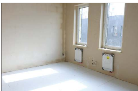
Podłogi na najwyższej kondygnacji są już przygotowane do położenia posadzek
