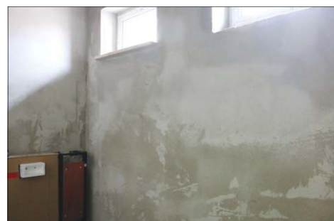
Łazienki dla zatrzymanych mają odpowiednio wysoko umiejscowione okna
