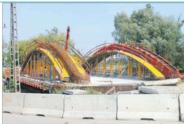
Nowy most na Pisi wyróżnia się konstrukcją łukową
