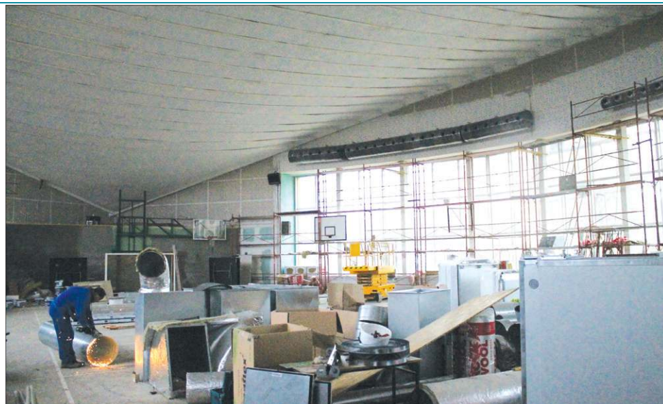
Ściany i sufit hali sportowej są już gotowe. Czekają teraz na malowanie
