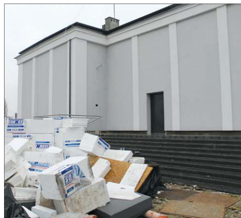
Ocieplone ściany SCK w Boryszewie
