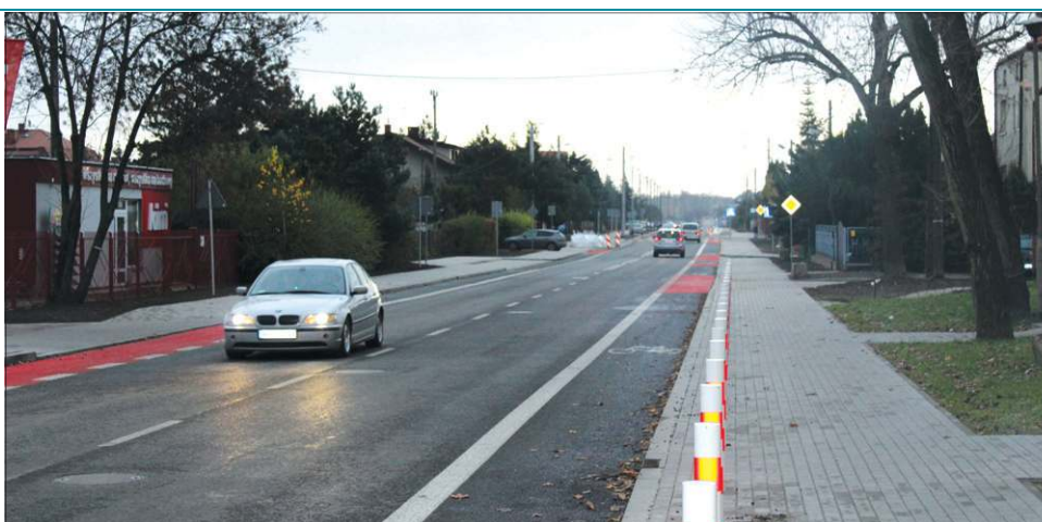
Dzięki dotacji zostanie zmodernizowany drugi odcinek ul. Trojanowskiej
