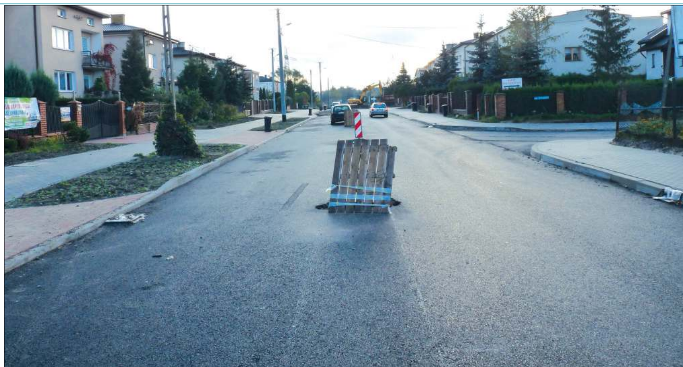
Na Trojanowskiej pojawiają się kolejne warstwy asfaltu
