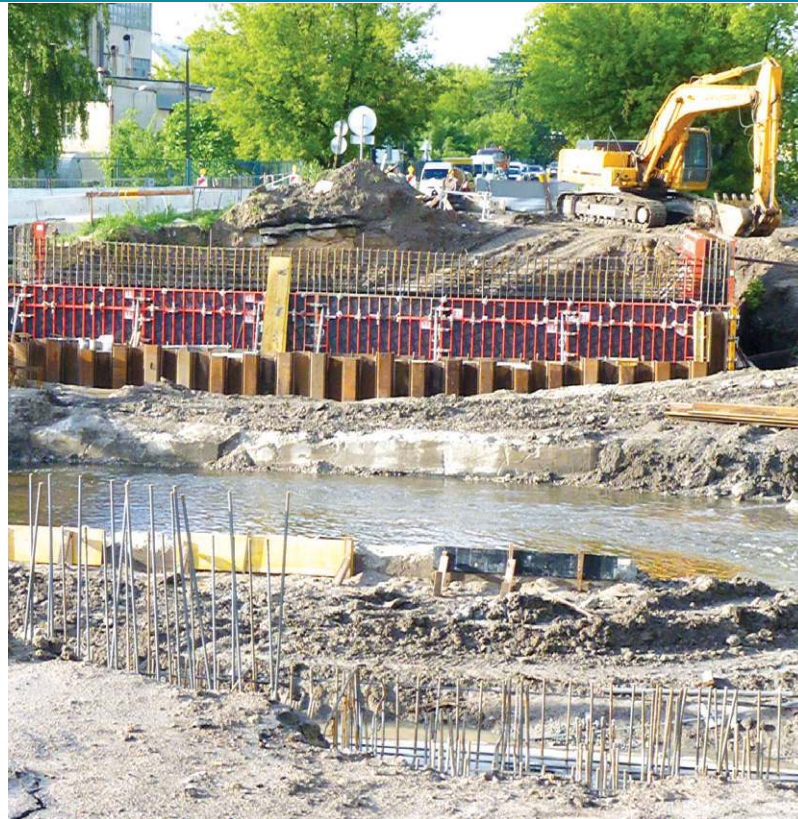
Trwa budowa przyczółków nowej przeprawy
