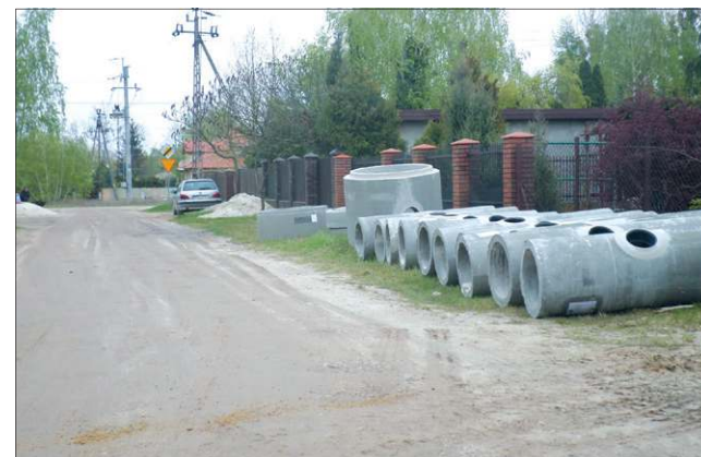
Rury i studnie już czekają na montaż. Najpóźniej w wakacje na obydwu drogach wylanych będzie 420 metrów asfaltu
