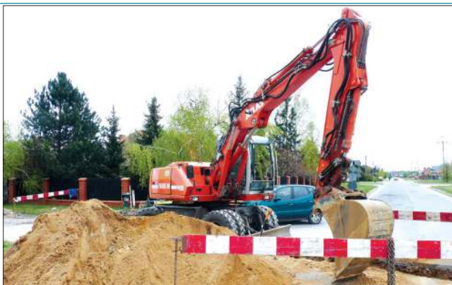
Po świętach ruszyła budowa kanalizacji deszczowej w ulicach Malinowej i Tęczowej. Drugim etapem będzie asfalt
