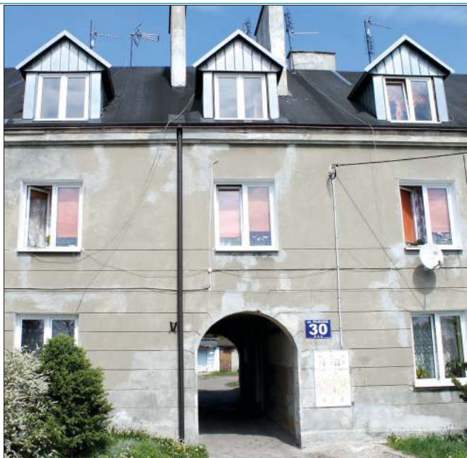
W zeszłym roku miasto wyremontowało dach na kamienicy przy ul. Płockiej, teraz lokatorzy mogą wykupić mieszkania
