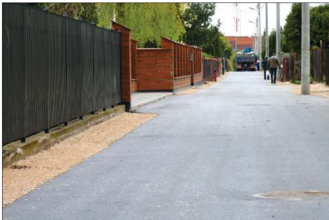
Prace w ul. Mireckiego, w dzielnicy Boryszew, już zakończone
