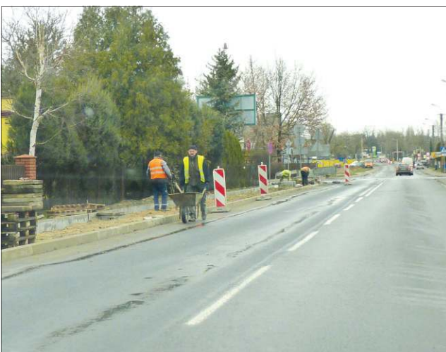
Na 15 Sierpnia wymienione będą chodniki, a potem wylana nowa warstwa asfaltu
