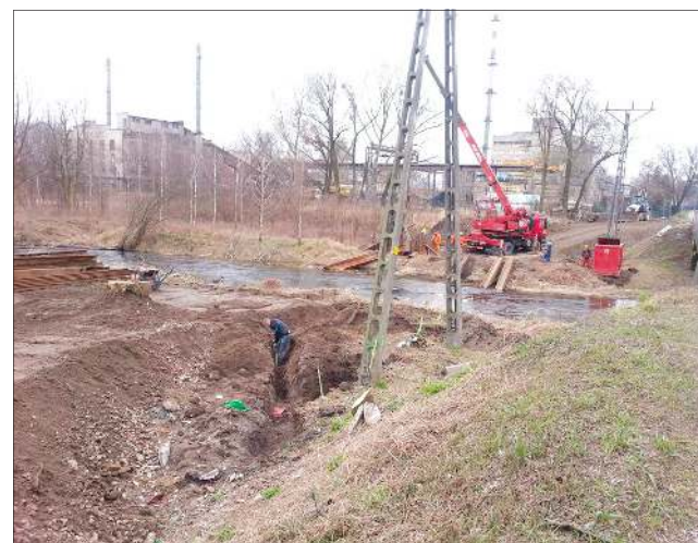
Wznowiono prace przy budowie przyczółków mostu na Pisi
