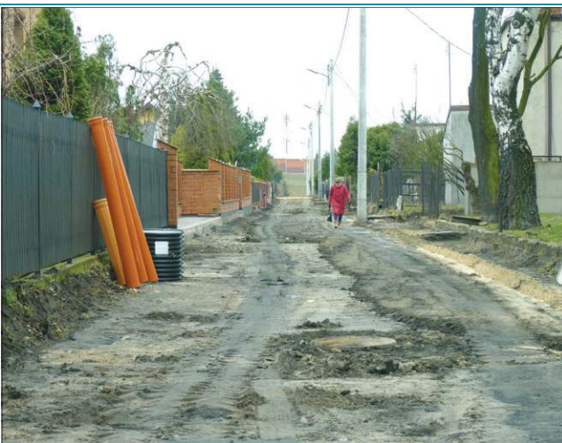
Na ul. Mireckiego, w dzielnicy Boryszew, wylewany będzie asfalt...
