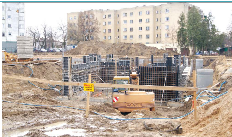
Na działce przy ul. 1 Maja trwają intensywne prace budowlane
