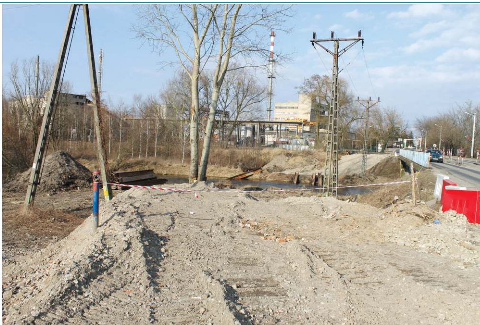
Tymczasowa przeprawa ma stać po prawej stronie, jadąc w kierunku Malesina
