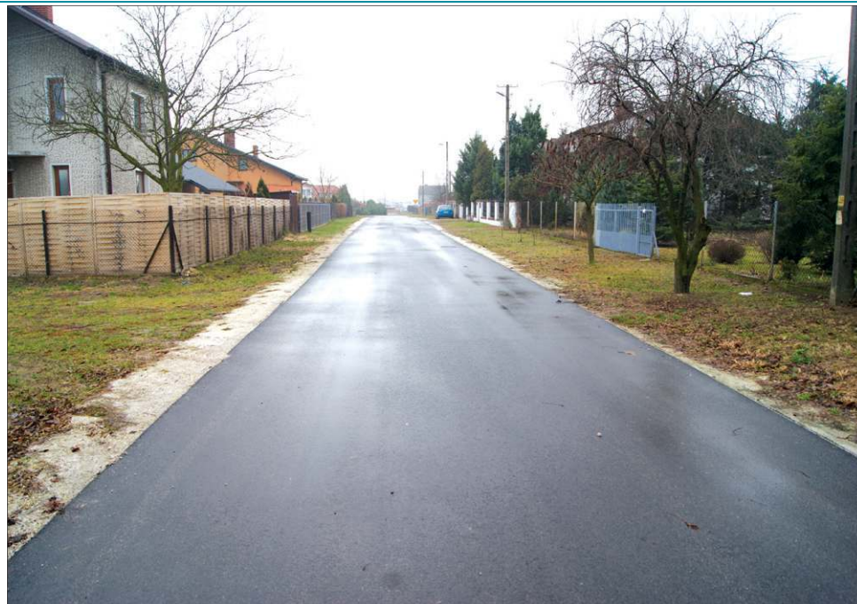
Nowy asfalt na ul. Równoległej powstał w ramach zeszłorocznej edycji programu „Drogi zamiast błota”
