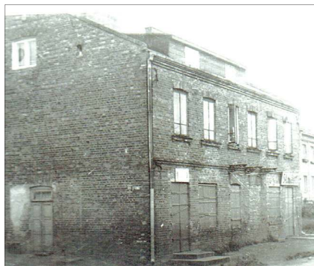
Dawny budynek szkoły przy Cegielni, dom państwa Przedpeńskich
