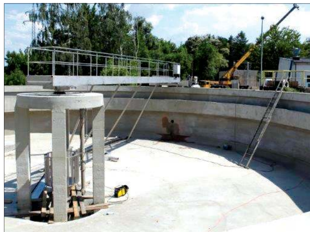
Remont osadnika wtórnego w oczyszczalni ścieków
