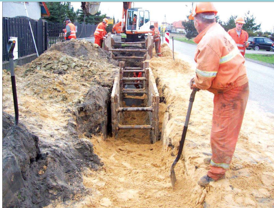
Budowa kanalizacji sanitarnej objęła 95 proc. miasta
