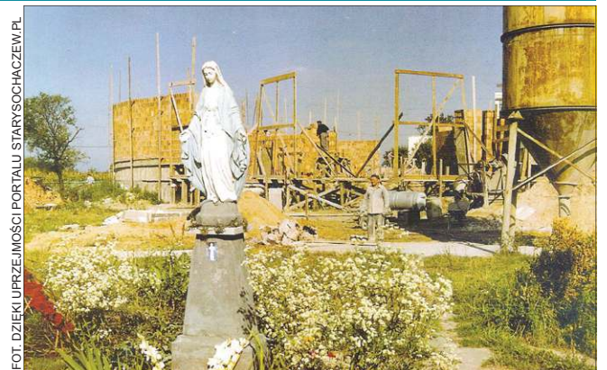
Pierwszy etap budowy kościoła w Boryszewie
