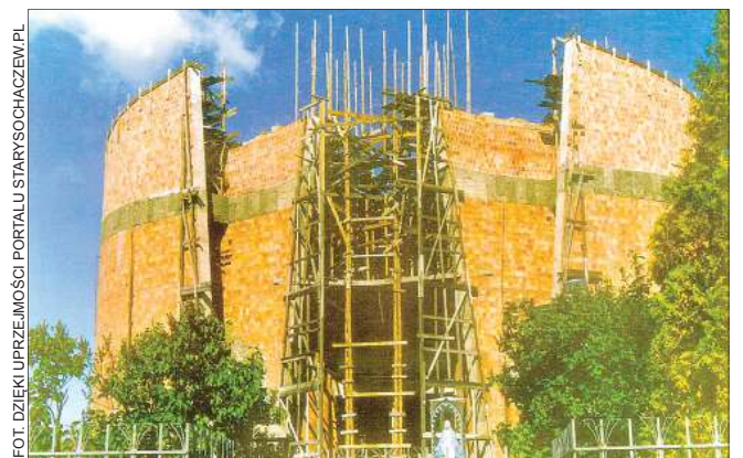
Mury już gotowe
