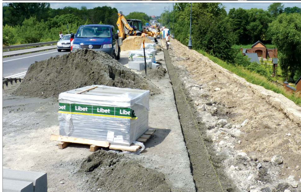
Remont był gruntowny. Jak zapewnia ratusz, wystarczy na wiele lat
